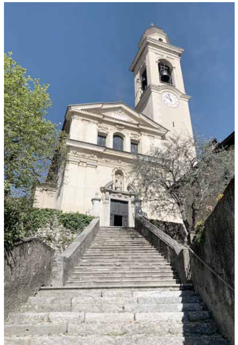
Vista della chiesa di San Martino
