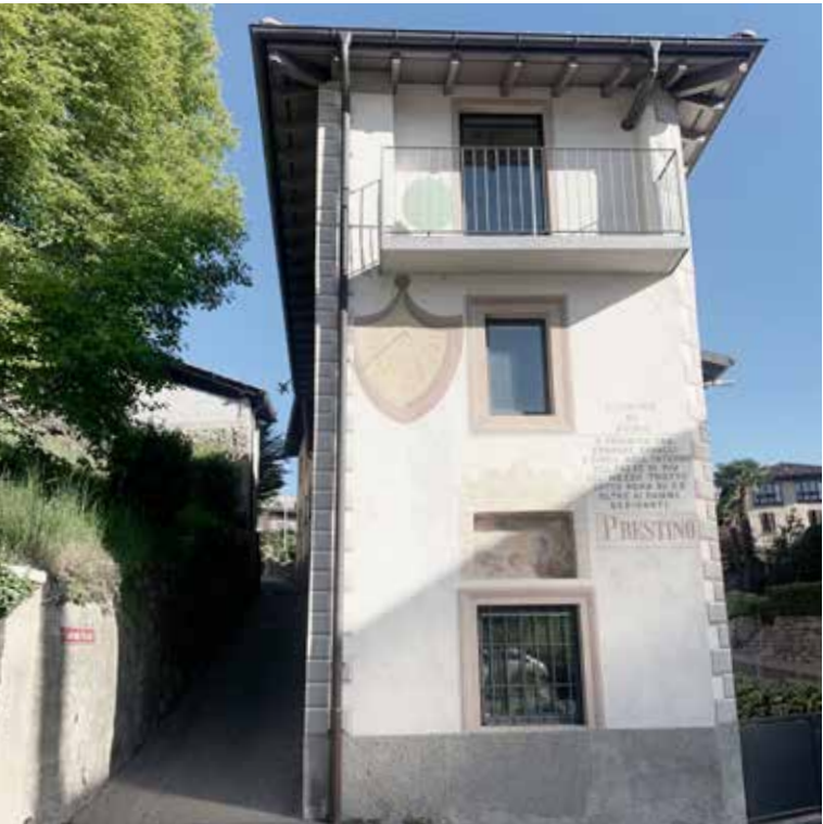
Edificio di nucleo, testata sud - edificio di pregio con fregi e affreschi
