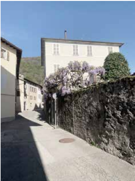
Edificio di nucleo - Contrada vecchia Cantonale
