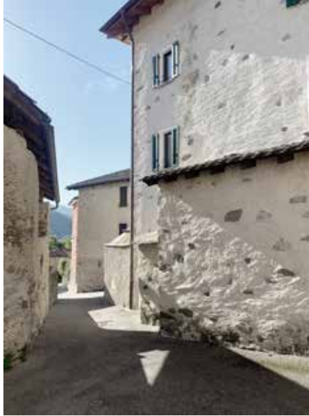
Edificio di nucleo - Contrada Cozóra
