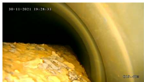
Fondo pozzo con depositi (-35.5 m)
