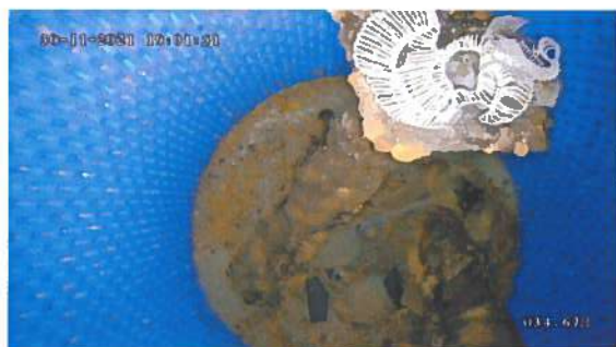
7, 00:17:02, 35.00m Ostacolo, / depositi duri presenti sul fondo
