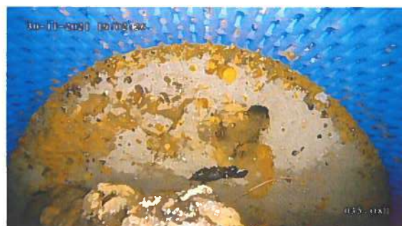
8, 00:17:02, 35.00m Ostacolo, / depositi duri presenti sul fondo
