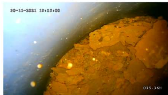
Fondo pozzo con depositi (-35.5 m)
