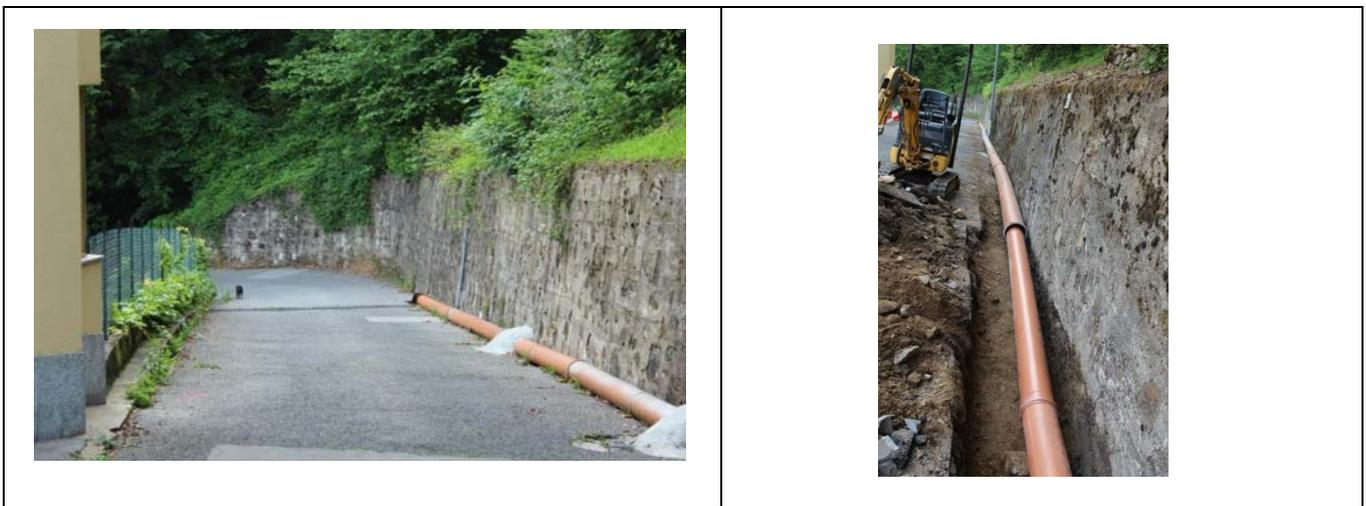
Figura 12 - By pass acque meteoriche lungo Via Prussiana
